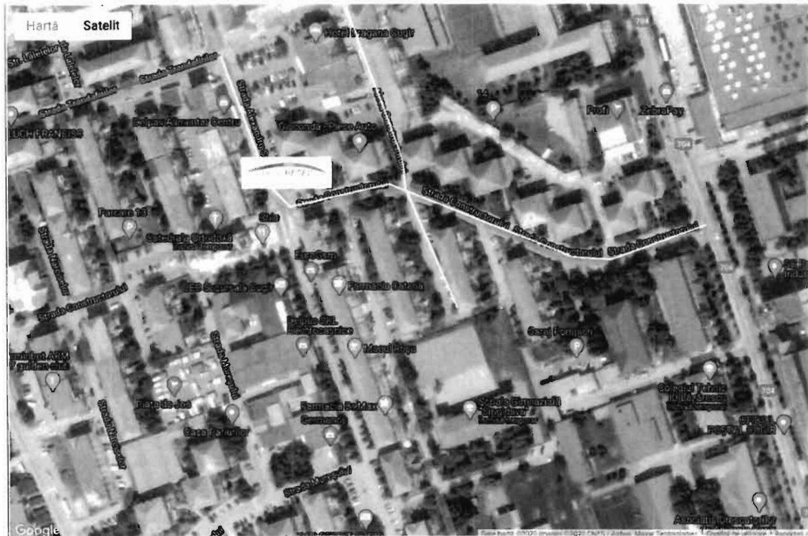
Fig.14: Un SISTEM DSRD funcțional, cu tronsoanele aferente. Se remarcă tronsonul aflat în construcție
