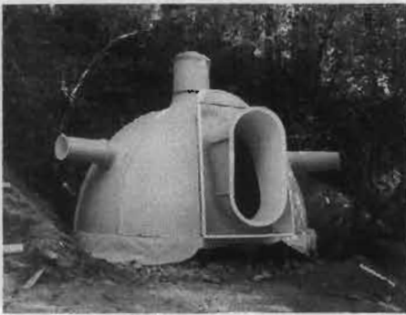
Fig.2. Exemplu adăpost subteran
