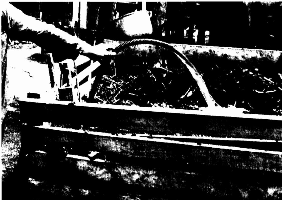
Foto 3a Transportul dejecțiilor lichide din fosa de colectare pe platformă cu ajutorul pompei de apă submersibile
